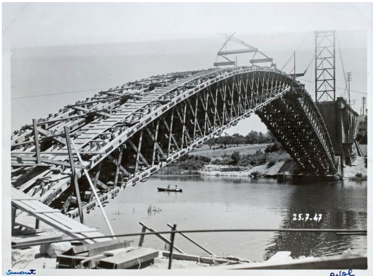
Vue du cintre en place, 25 juillet 1947.
