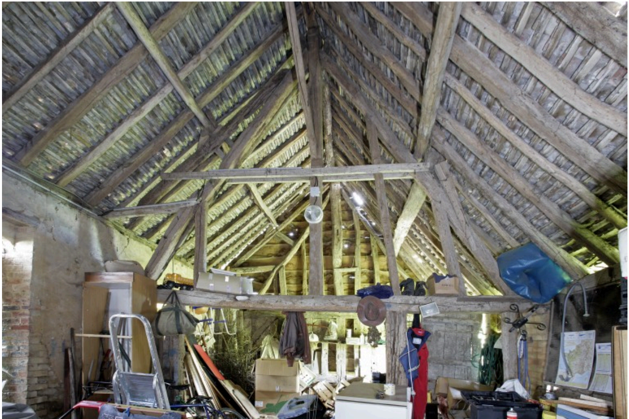
Remise, intérieur : vue générale.
