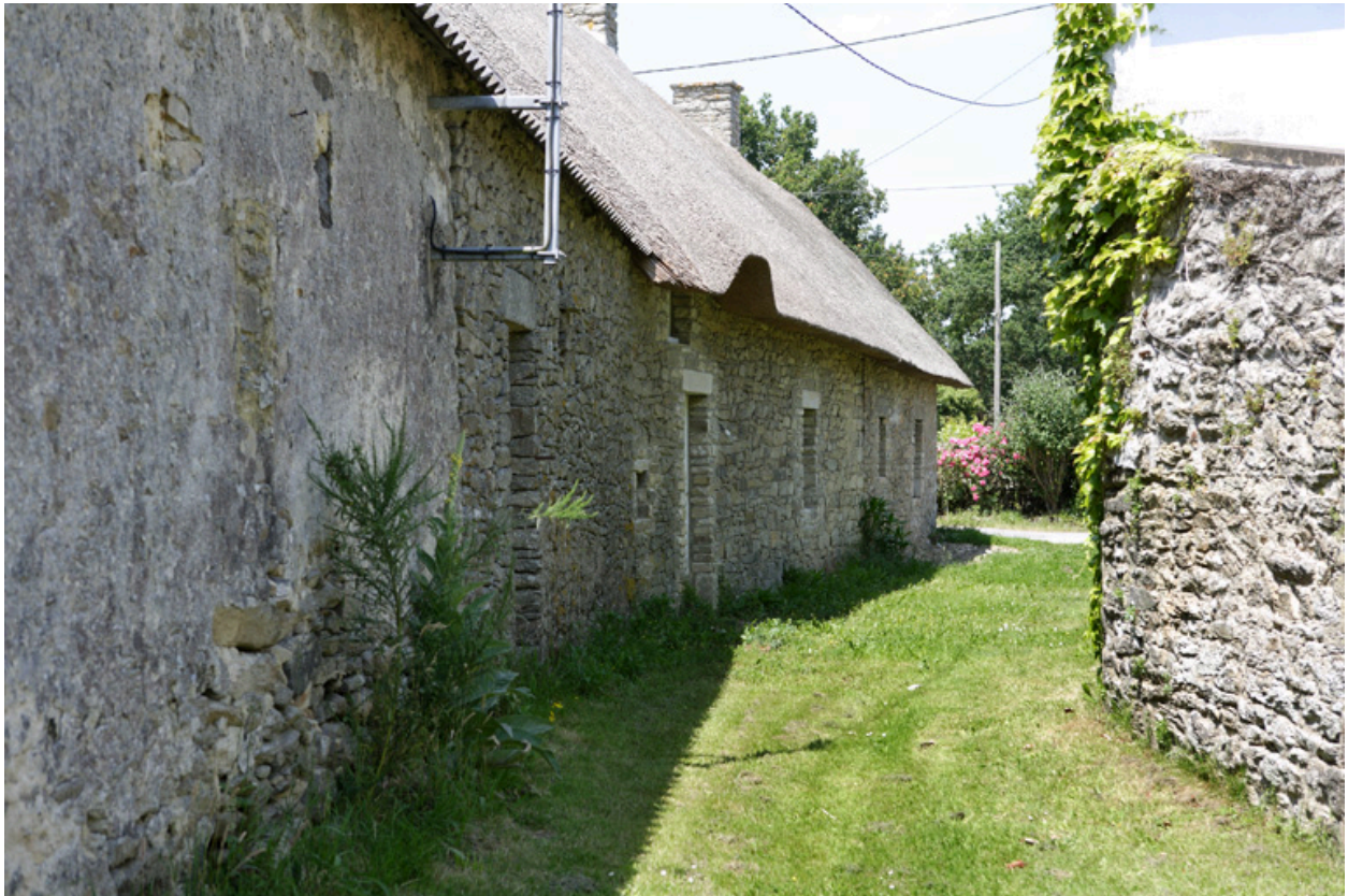
Vue de la façade arrière depuis le sud.
