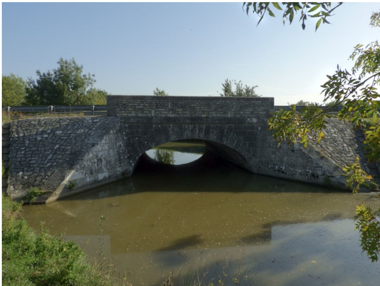
Le pont vu depuis le sud, côté aval.
