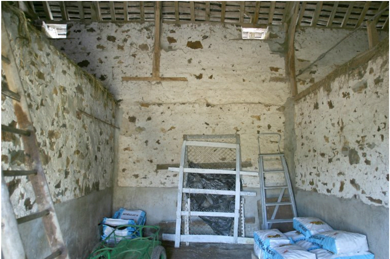
L'étable-grange, vue intérieure. Le fond de grange vu de l'est.
