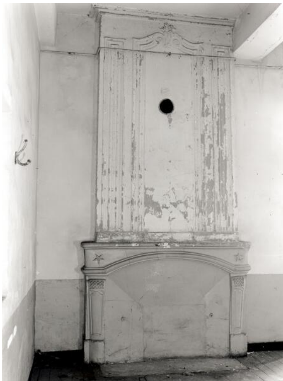
Aile ouest du cloître, deuxième étage, pièce nord, mur ouest : cheminée, vue d'ensemble.
