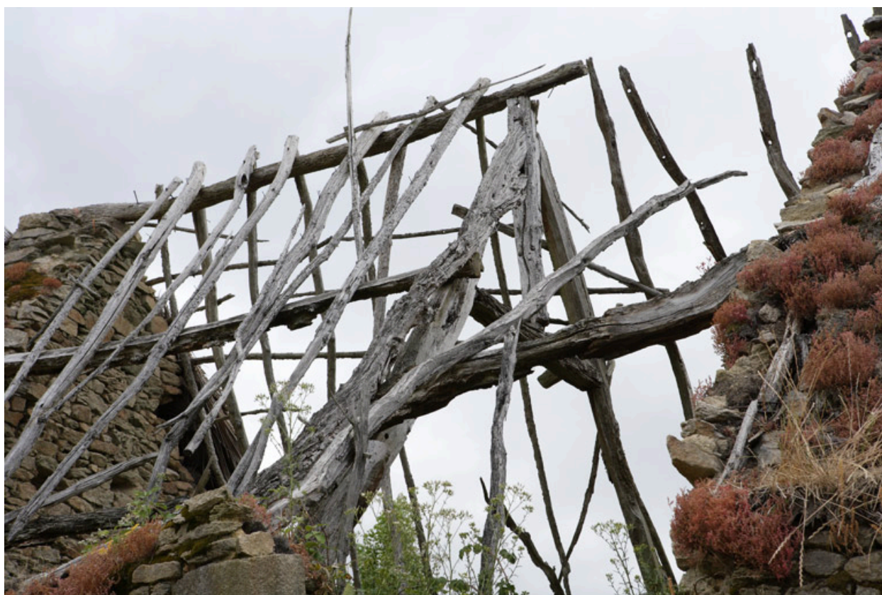
Détail de la charpente.
