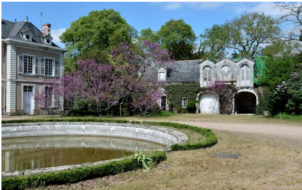
Mantelon. Vue de l'aile de commun nord.
