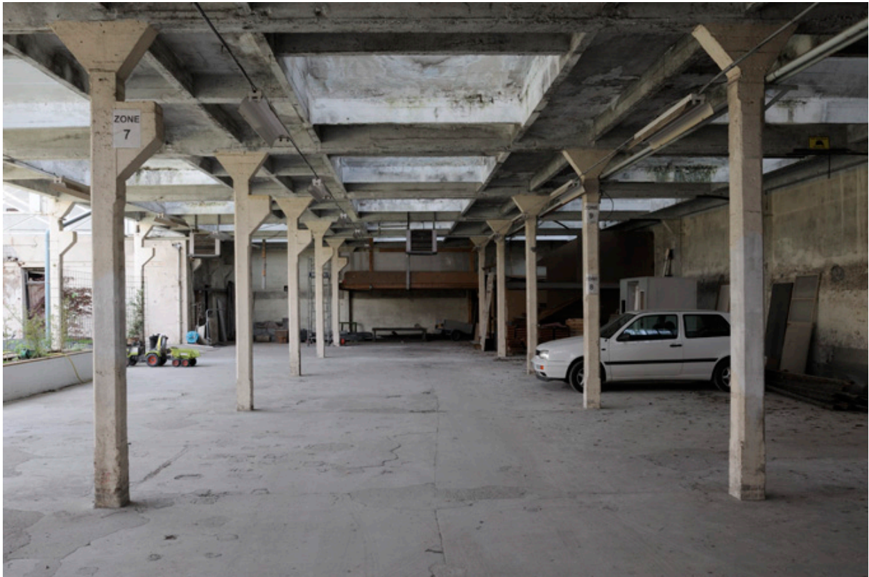
Vue intérieure de la première usine, datant des années 1920.
