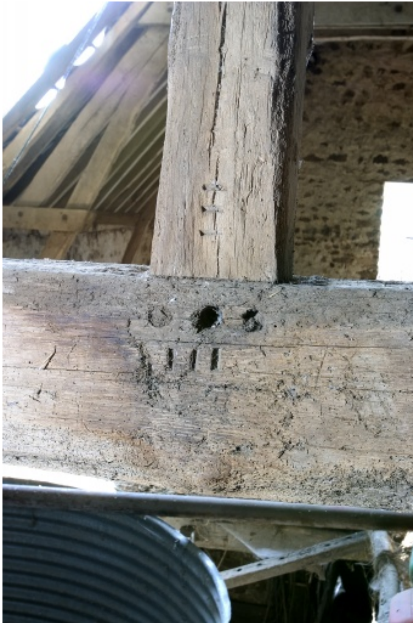
Détail de la charpente de l'étable-grange : marques d'assemblage.
