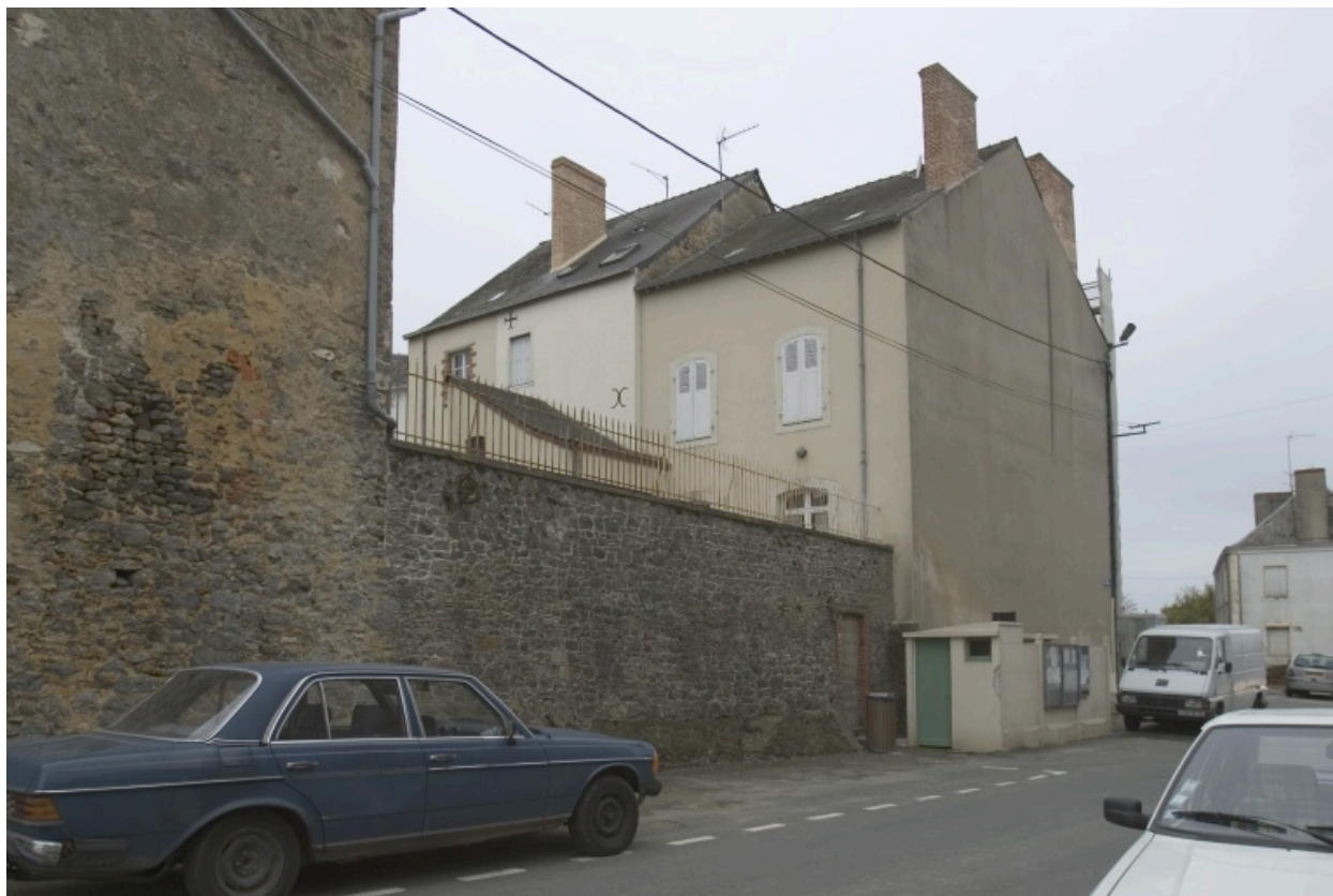
Vue de la façade postérieure depuis la rue de l'ancienne gare.
