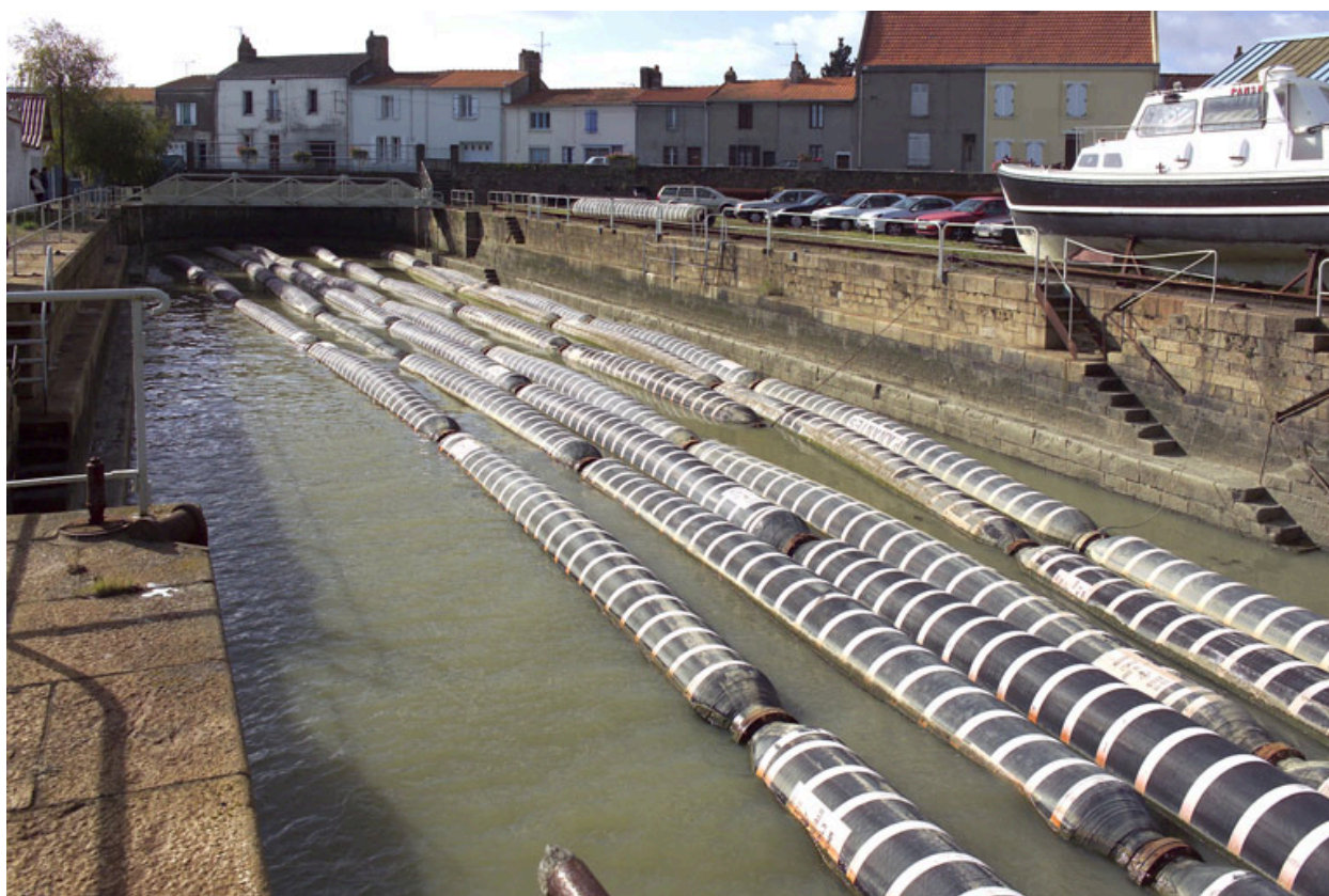
Vue partielle du quai Albert-Chassagne depuis la cale.
