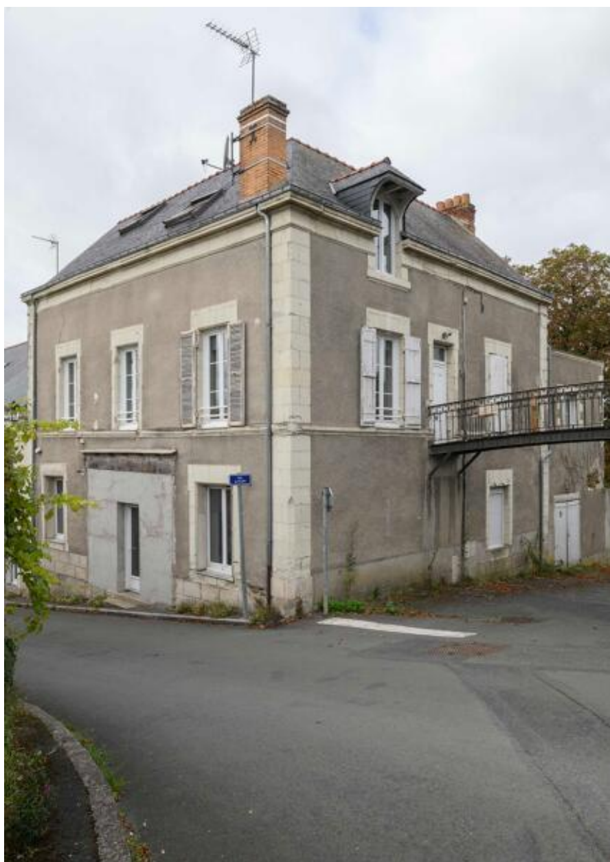
Maison, 15 rue du Pilon.
