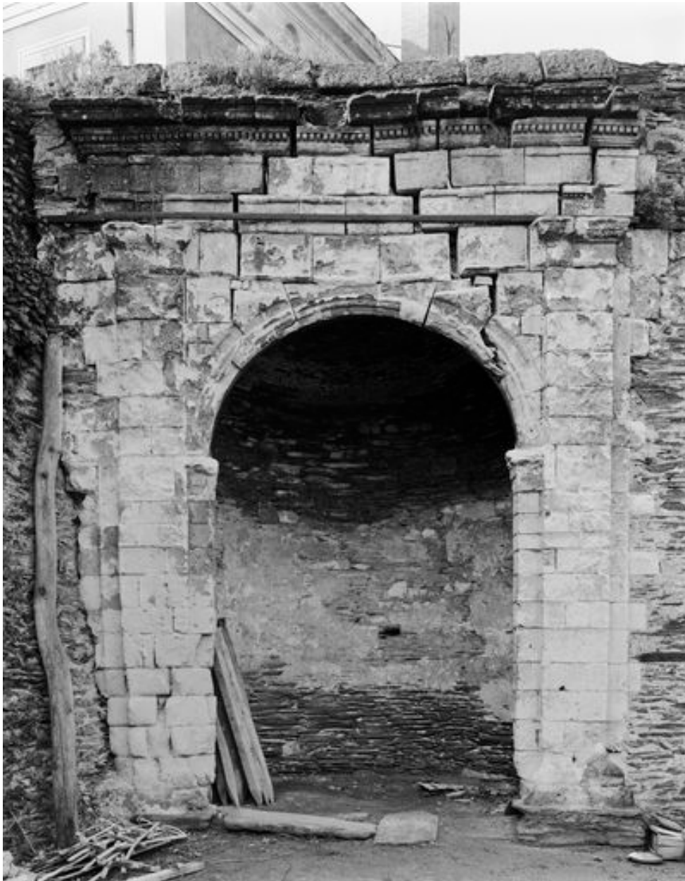
Abbaye, édicule voûté situé à l'angle sud-ouest des jardins méridionaux (disparus) : élévation antérieure.
