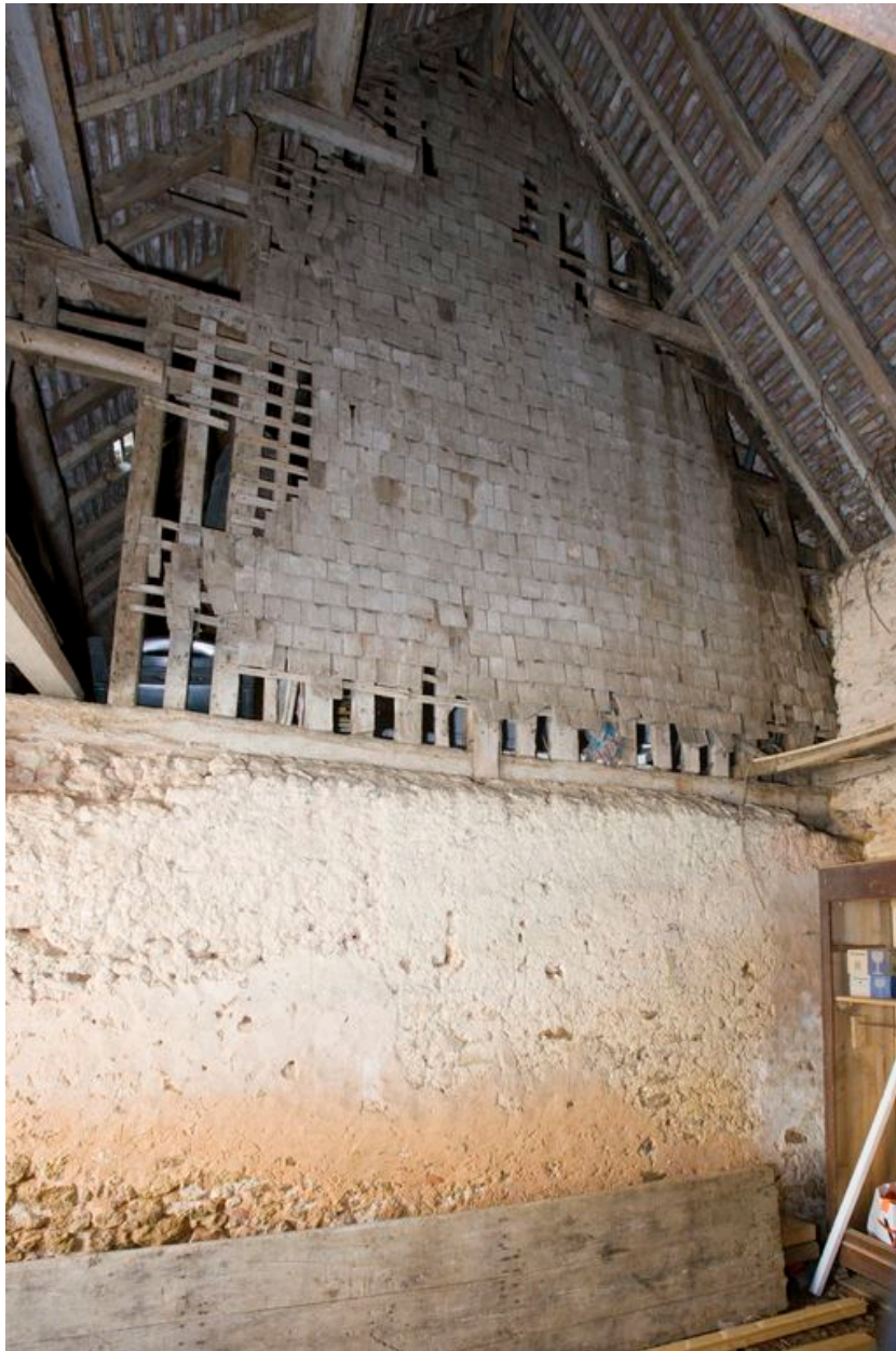
Pignon essenté de bardeaux du logement, vu depuis la grange.
