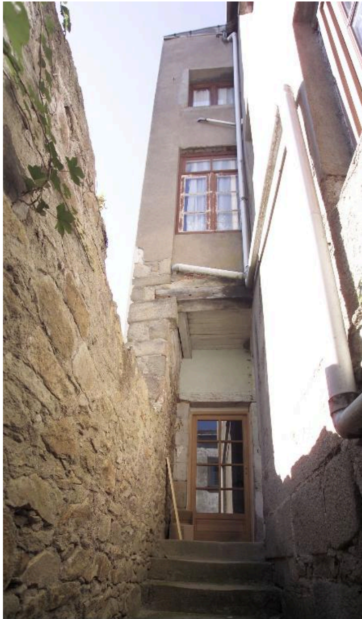
La façade postérieure du corps principal visible depuis l'allée.
