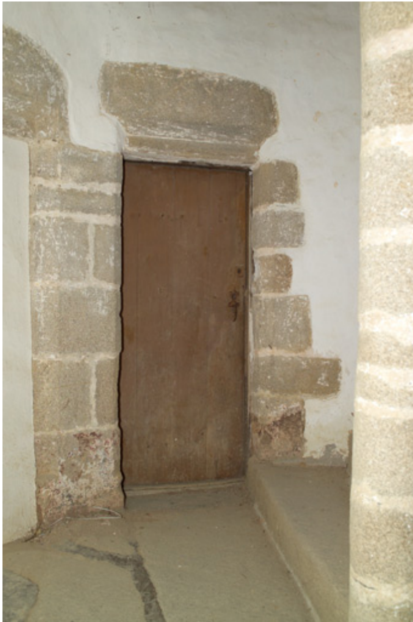
Escalier en vis, palier de l'étage, détail de la porte occidentale.
