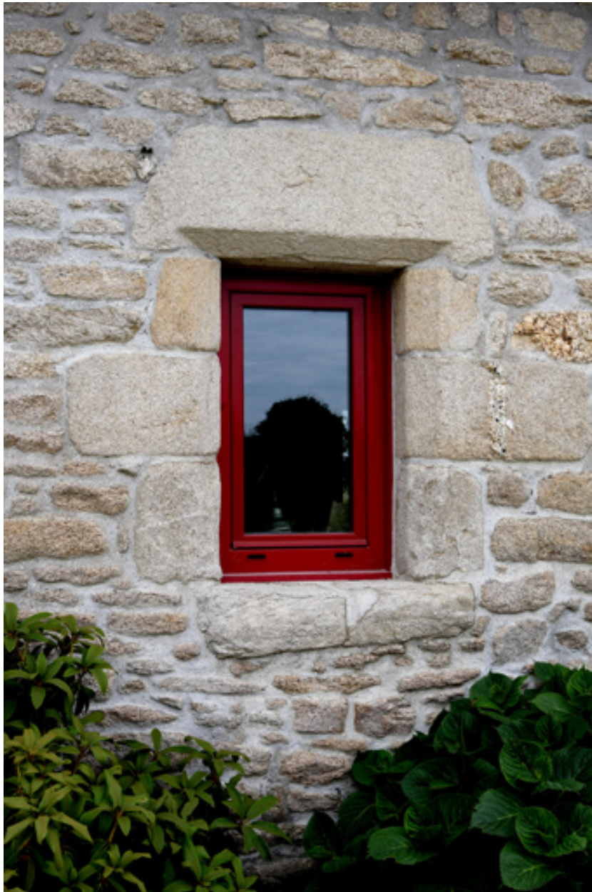
Logis. Façade nord. Détail d'une baie.
