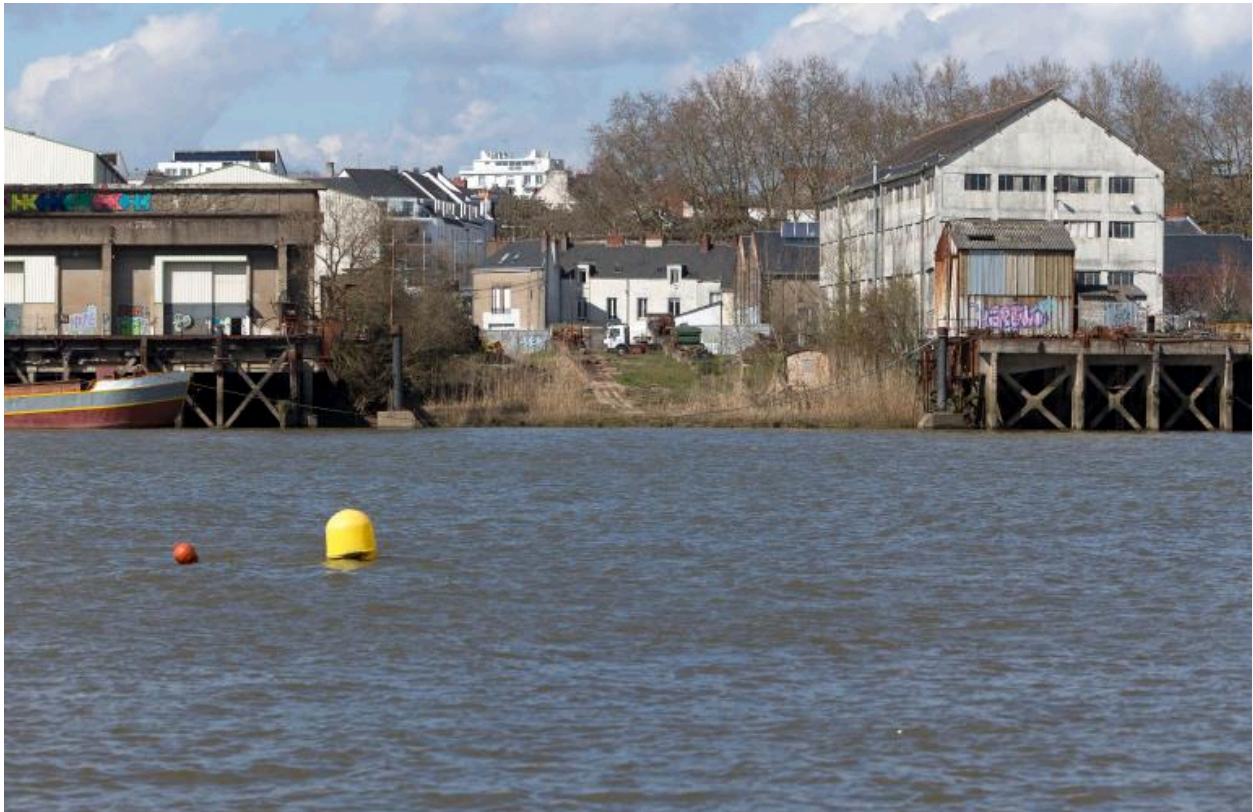
Vue sur les anciens chantiers depuis la Loire : salle à tracer et cale.
