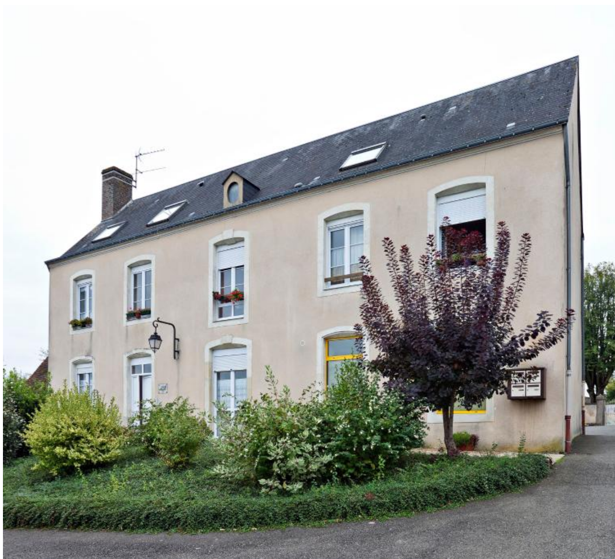
Ancien presbytère : façade nord.
