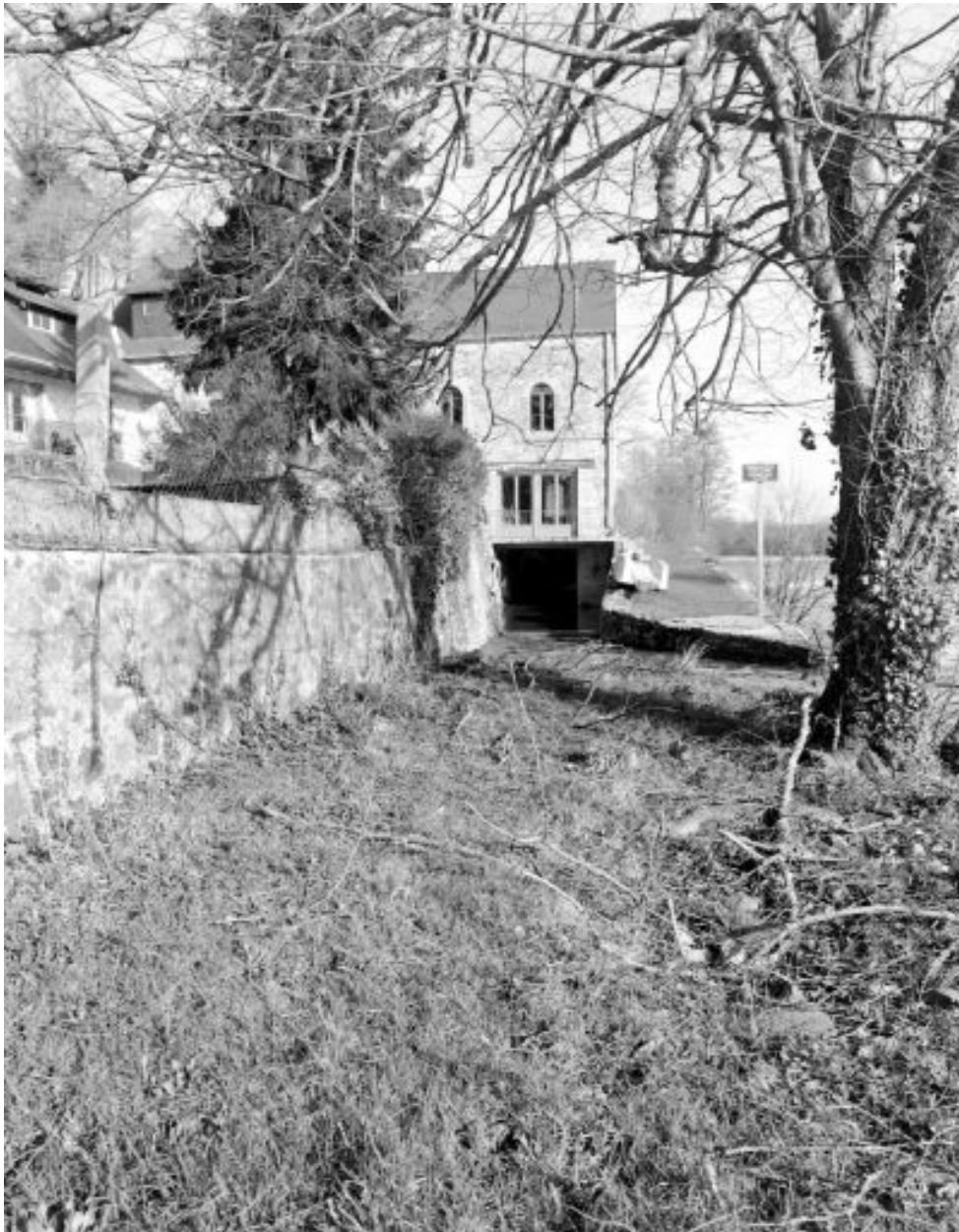
Le canal de fuite.
