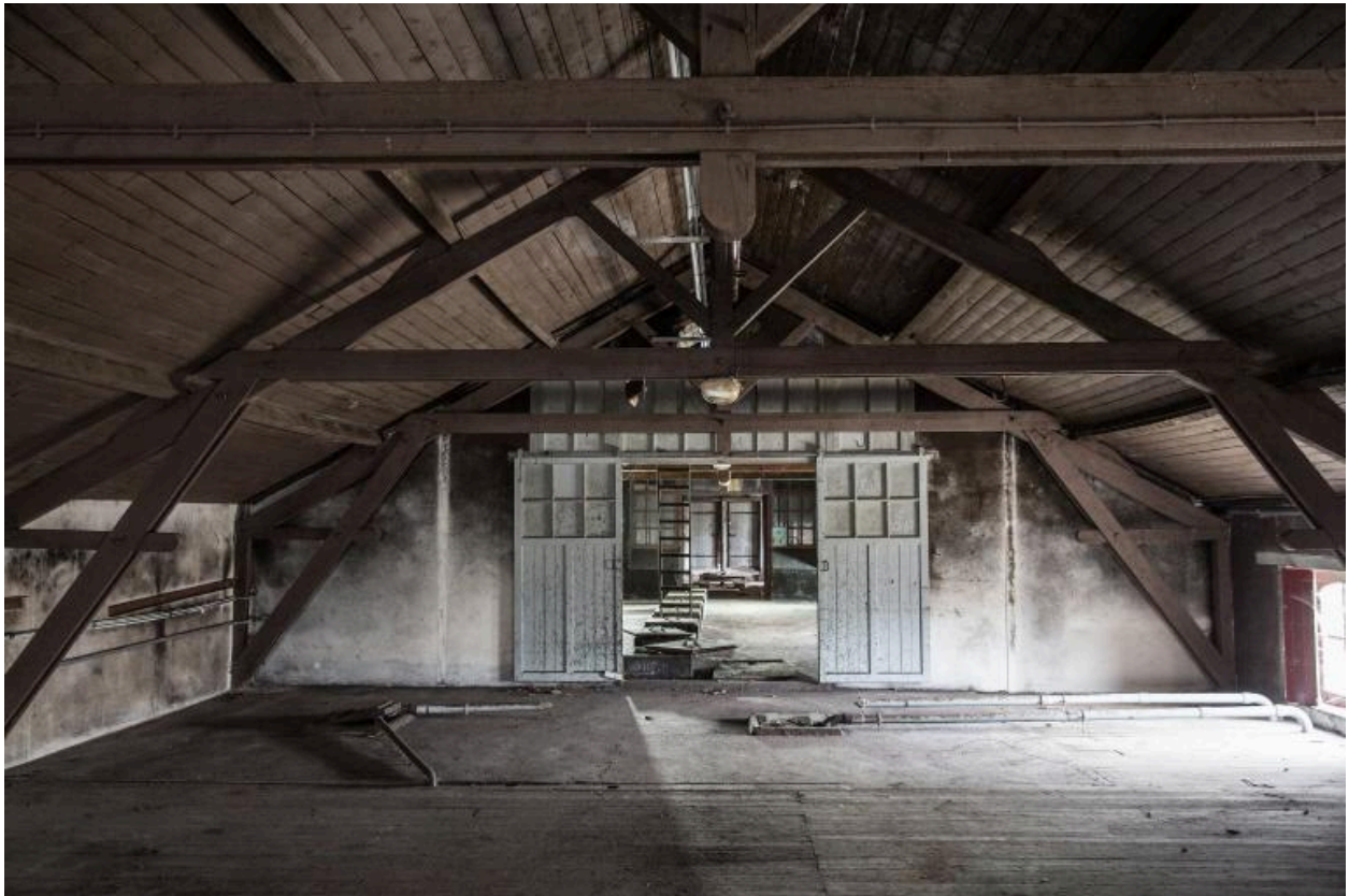
Chai sud, vue d'ensemble du premier étage : enfilade des charpentes, portes et dessus des cuves, 2018.
