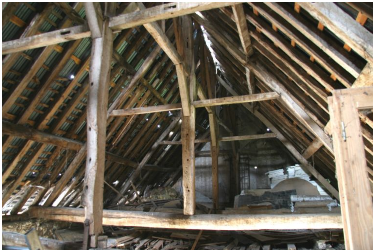
Salle médiévale : charpente très remaniée.
