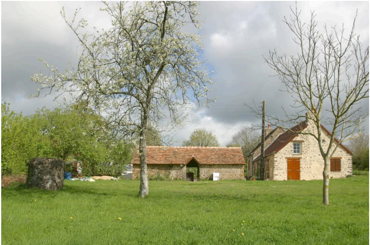
Vue d'ensemble depuis le sud : toit à porcs-remise, logis est.
