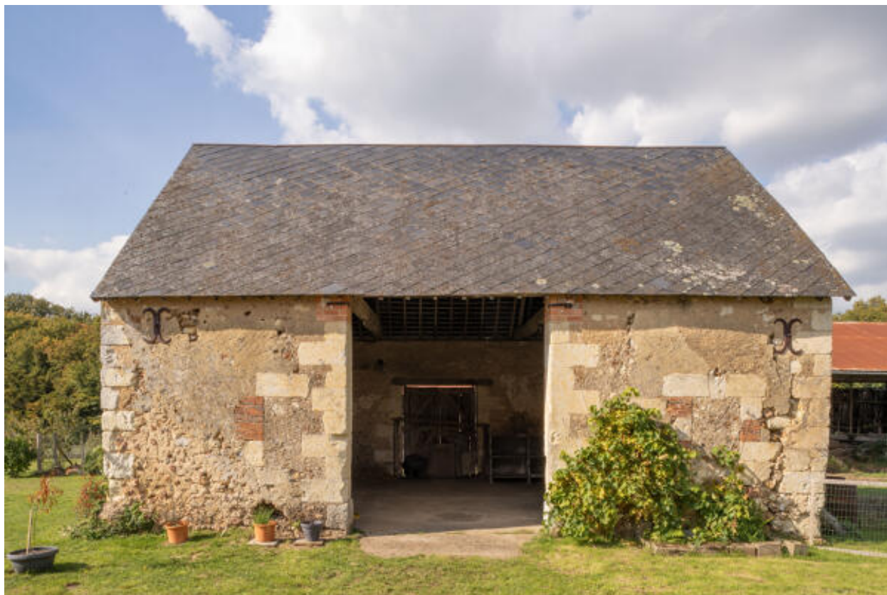
Ancien logis transformé en grange : vue frontale.
