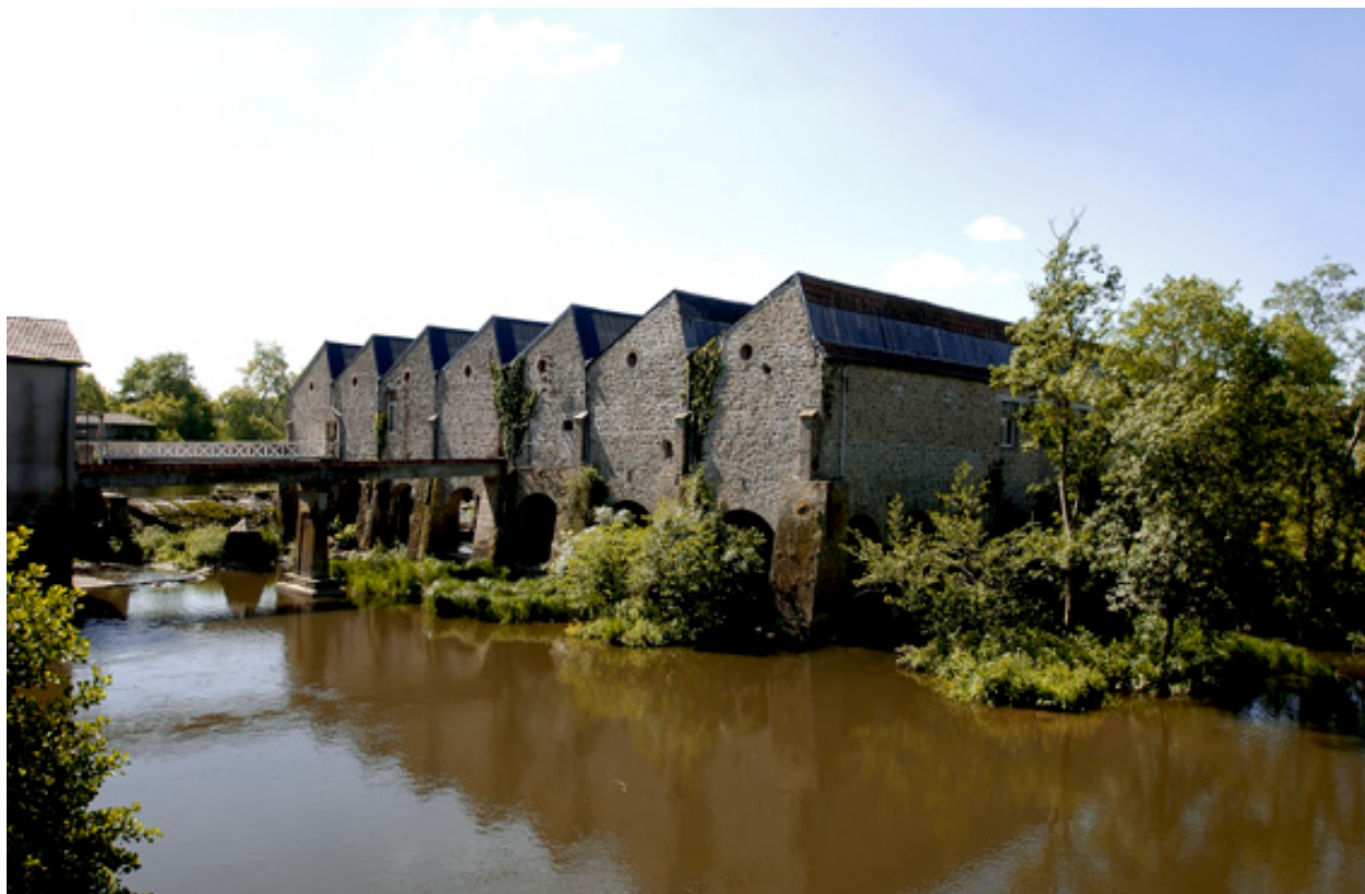
Vue générale des anciens ateliers de tissages mécaniques (1887). Ensemble depuis l'ouest.
