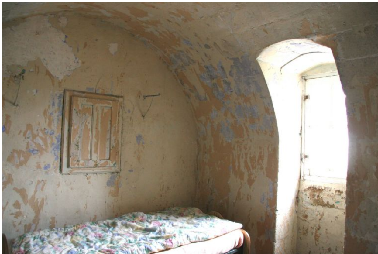
Premier étage de la tour : salle voûtée.
