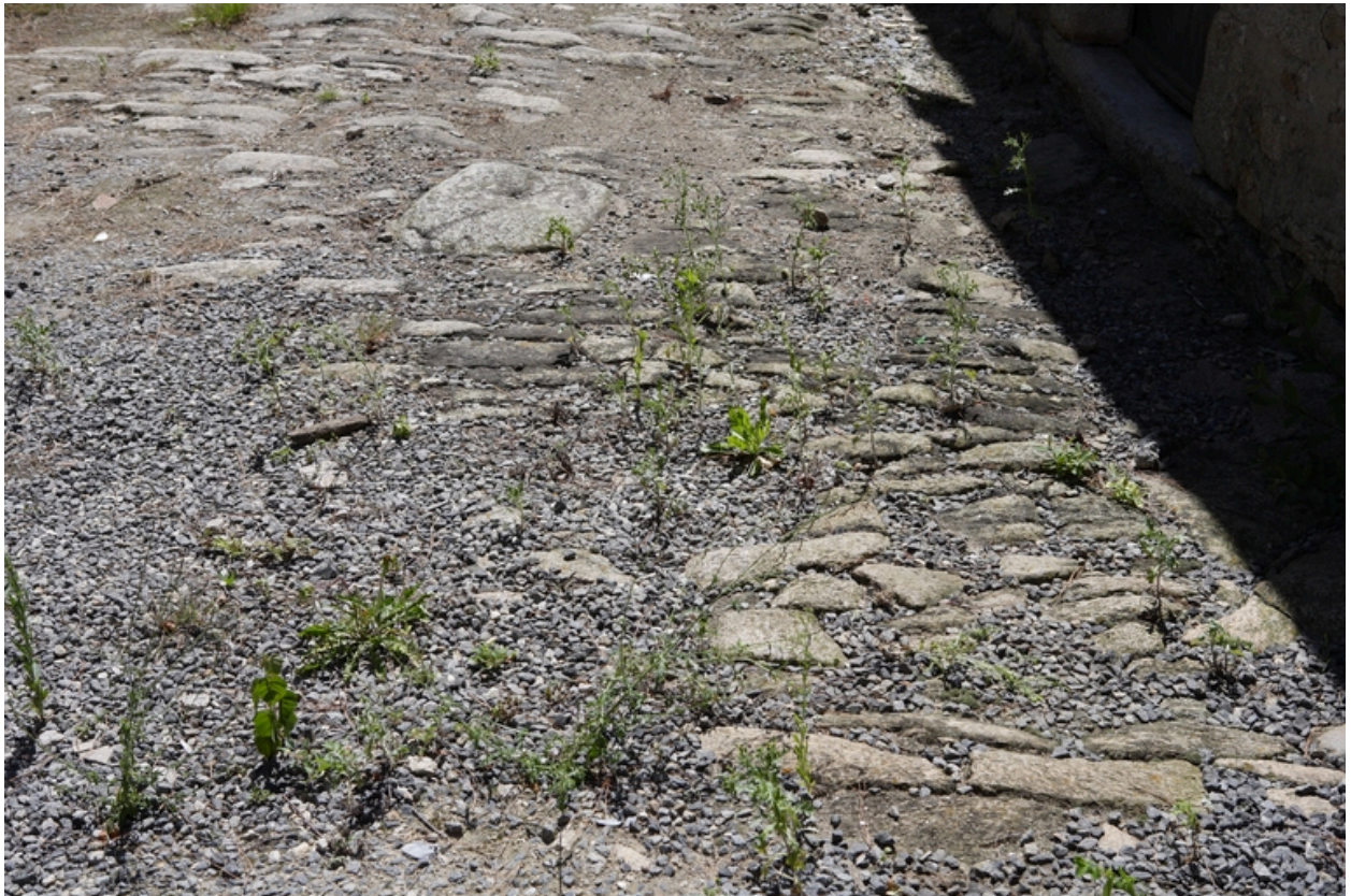
Cour. Détail du pavage.
