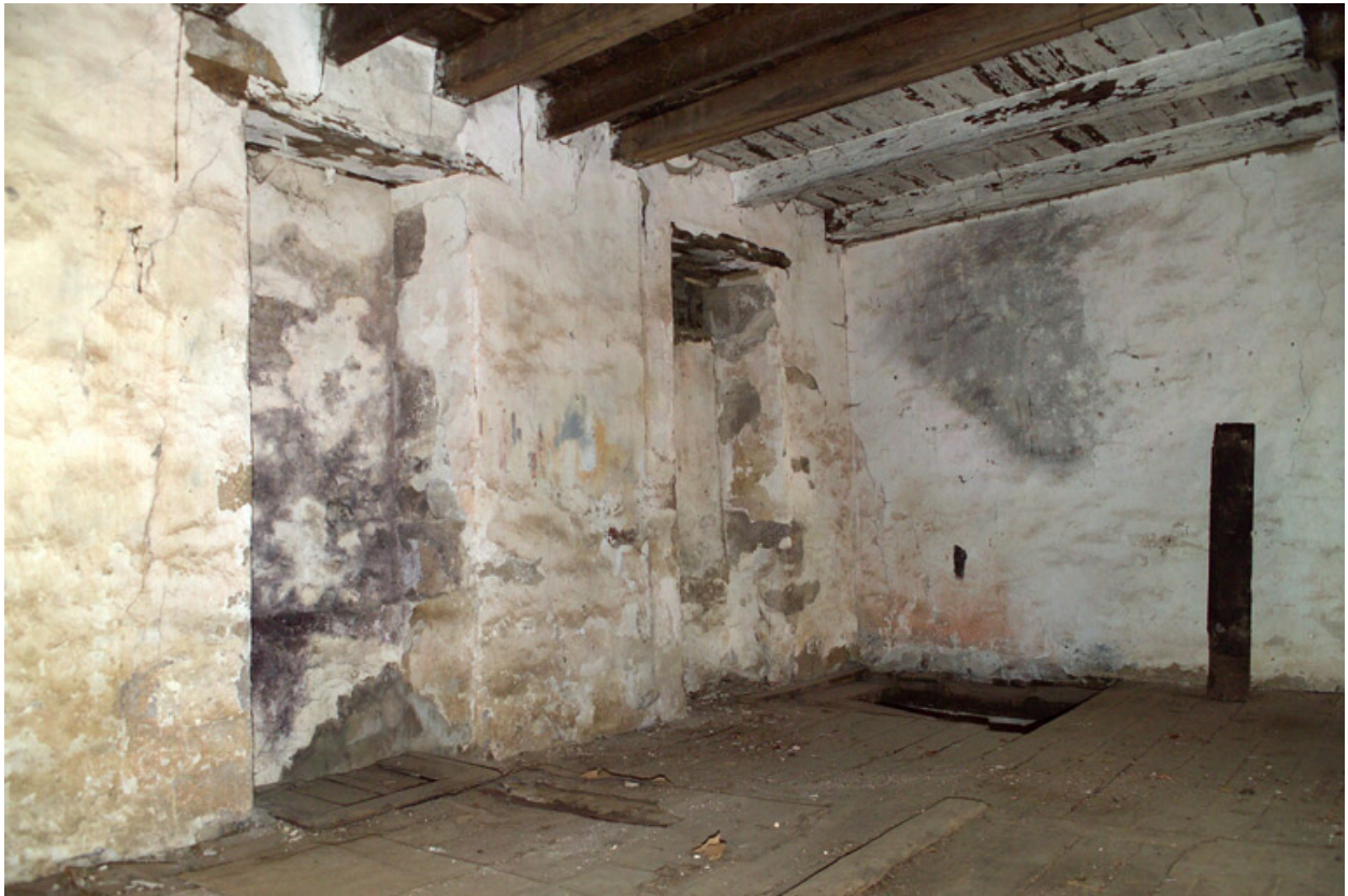
Aile sud, pièce orientale, premier étage, vue vers le sud-ouest.
