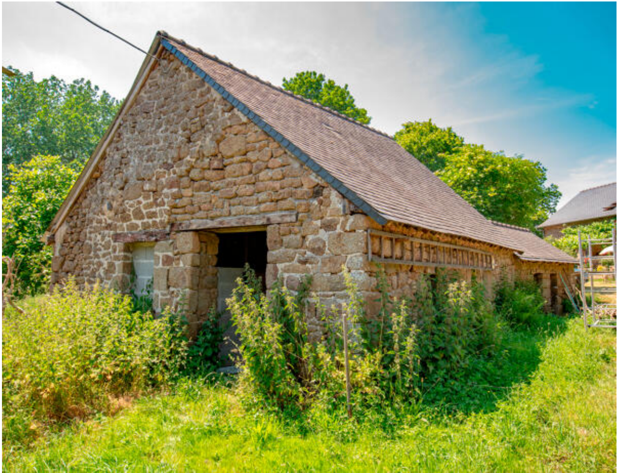
Bâtiment 2, mur-pignon oriental.
