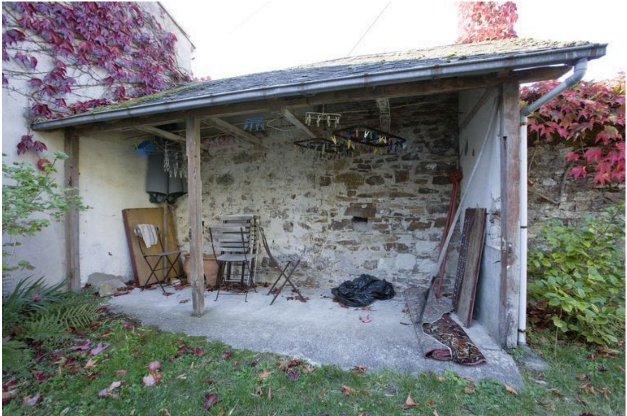
Anciennes latrines devenues préau.
