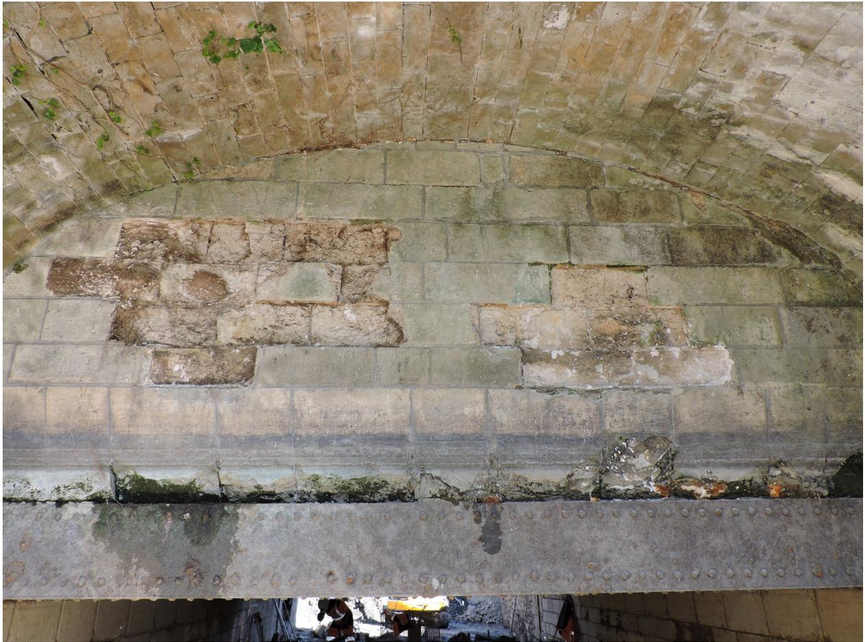
Août 2020 : pierres de taille dégradées au-dessus du radier en fonte, côté aval.
