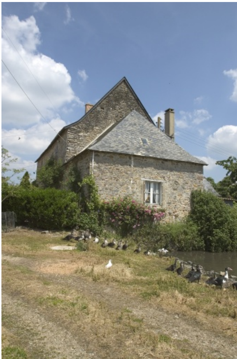
Le logis. Elévation latérale sud.
