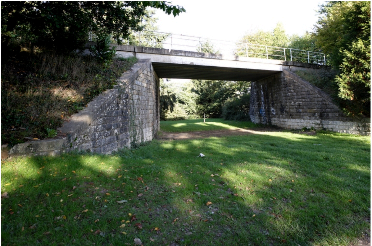
Pont à poutrelles enrobées.
