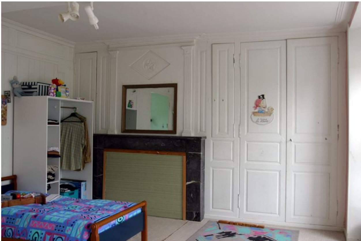
Premier étage, pièce nord : le mur nord et la cheminée.
