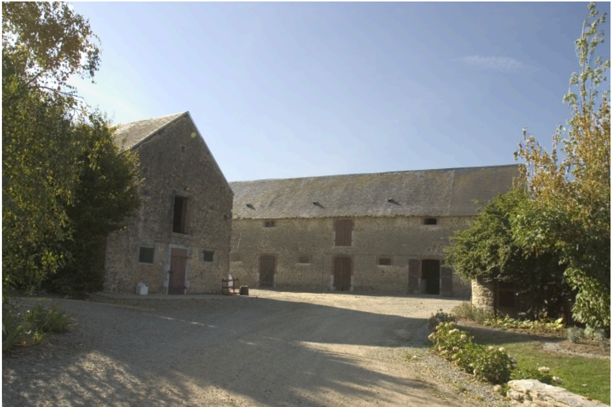
L'étable à chevaux et la seconde étable-grange vues depuis le nord.
