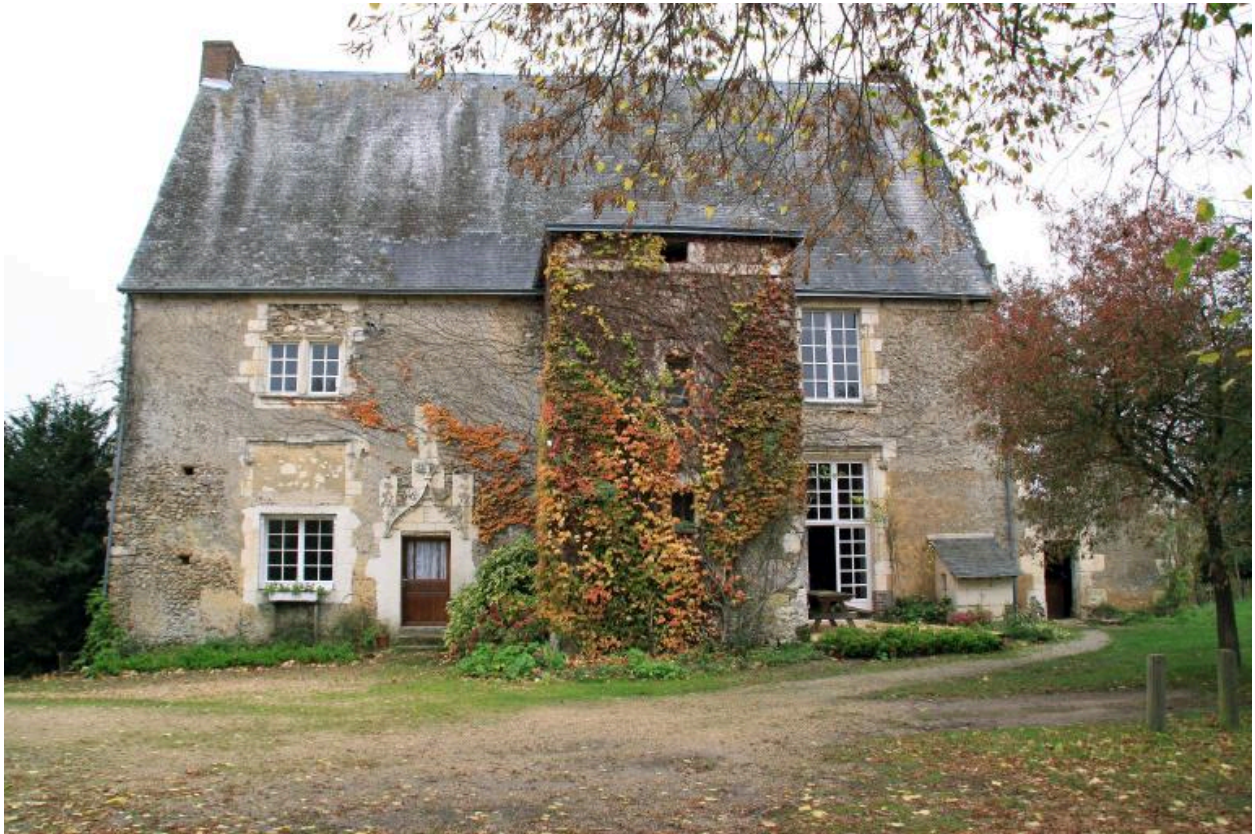
Façade antérieure sur cour.
