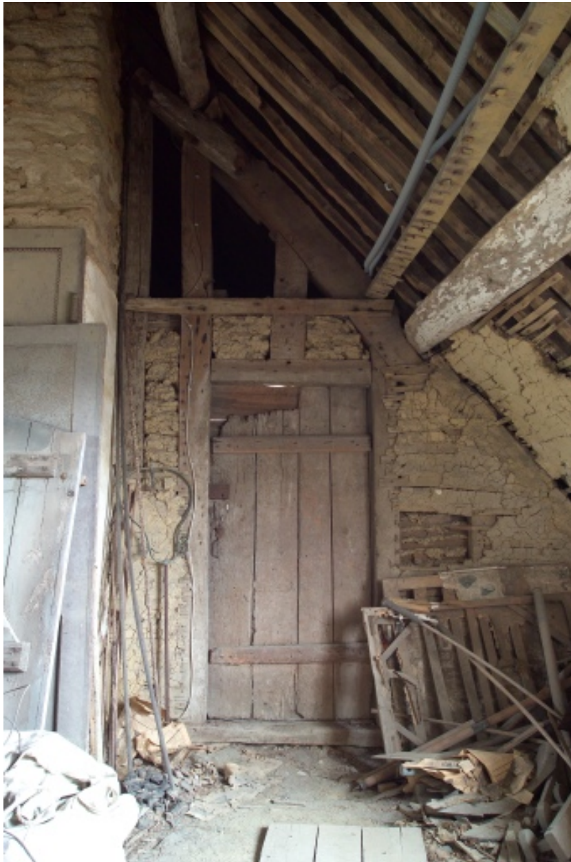
Cloison de torchis sur lattis dans le comble.
