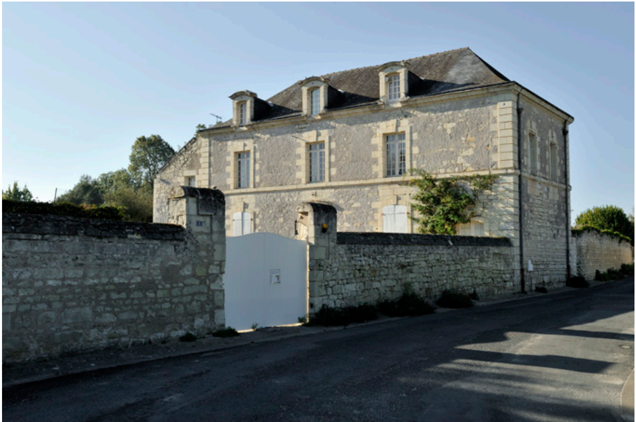
Vue d'ensemble depuis la rue.
