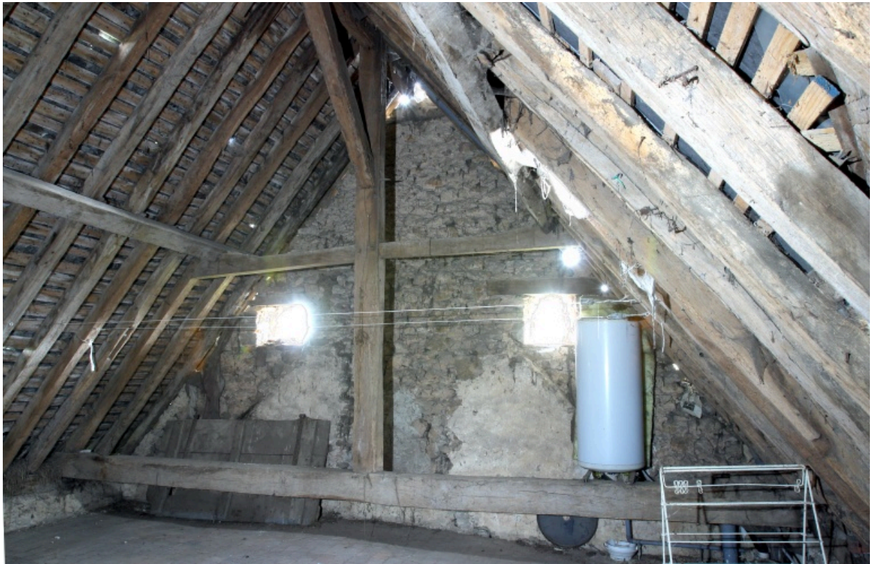
Comble du corps nord : la charpente vue depuis l'ouest.
