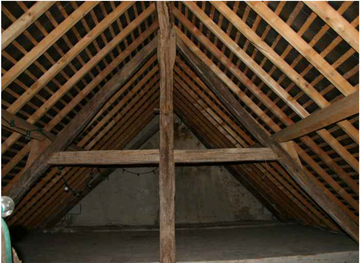
Charpente de la maison.
