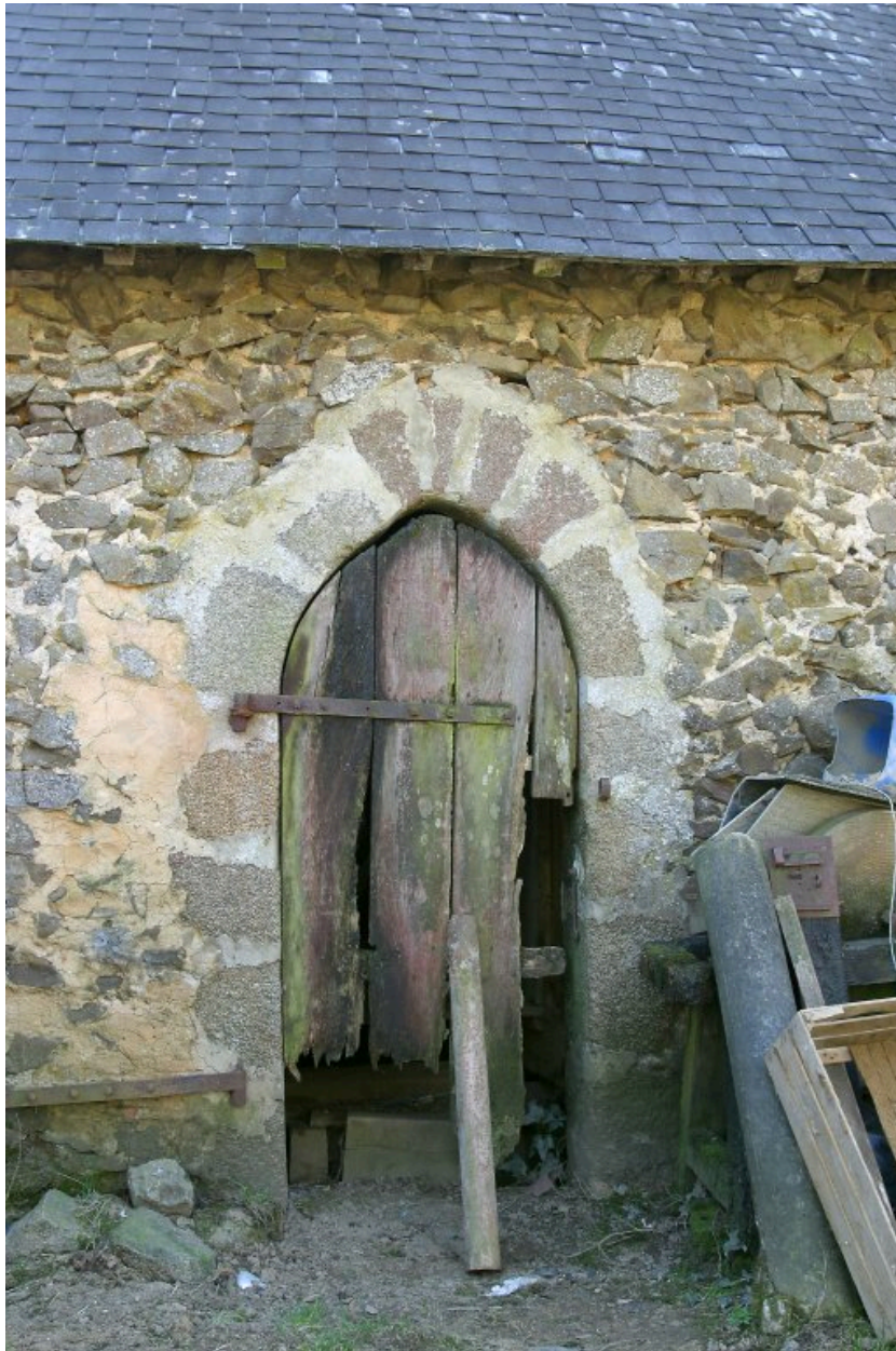
La chapelle. Porte s'ouvrant sur la façade nord.
