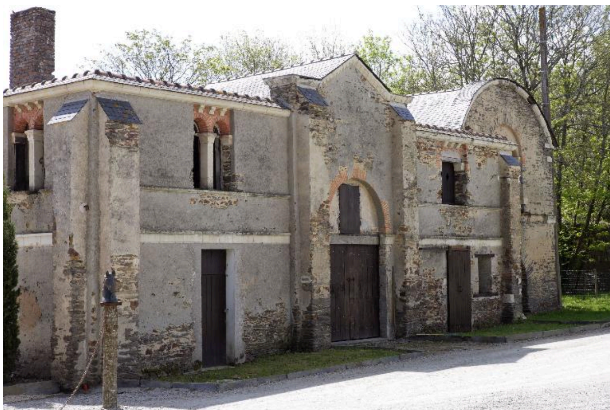
Bâtiment ouest, façade nord.
