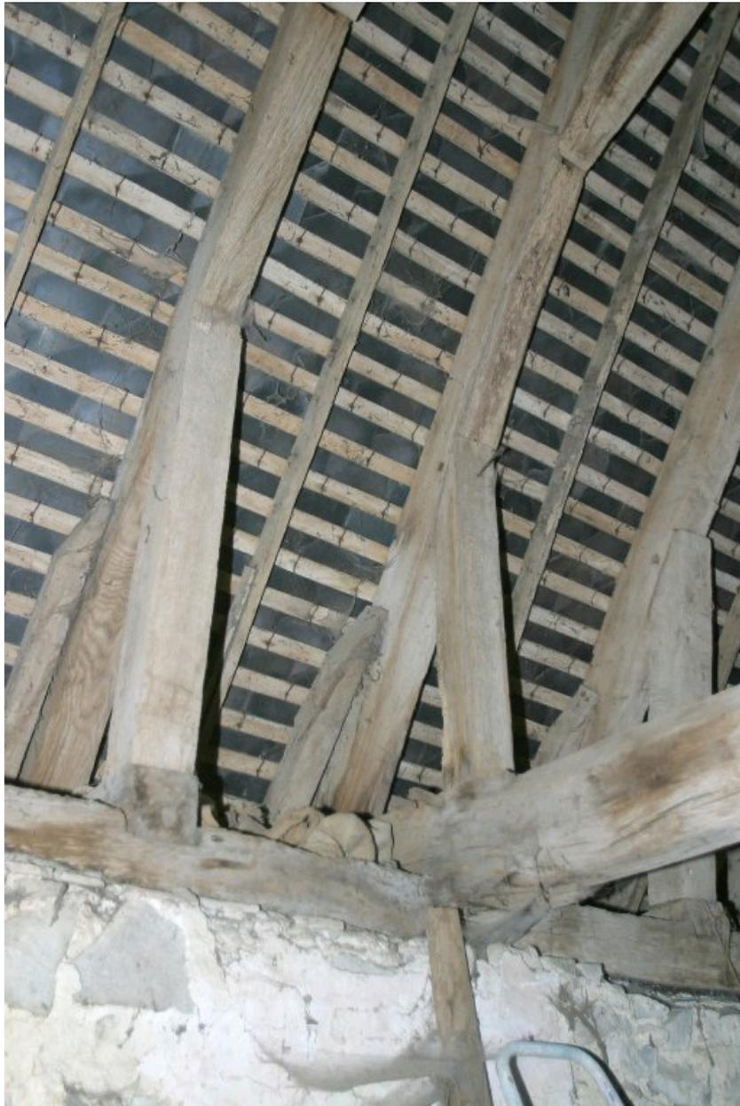
La chapelle, charpente. Détail de l'assemblage de la ferme centrale sur le mur-gouttereau nord.
