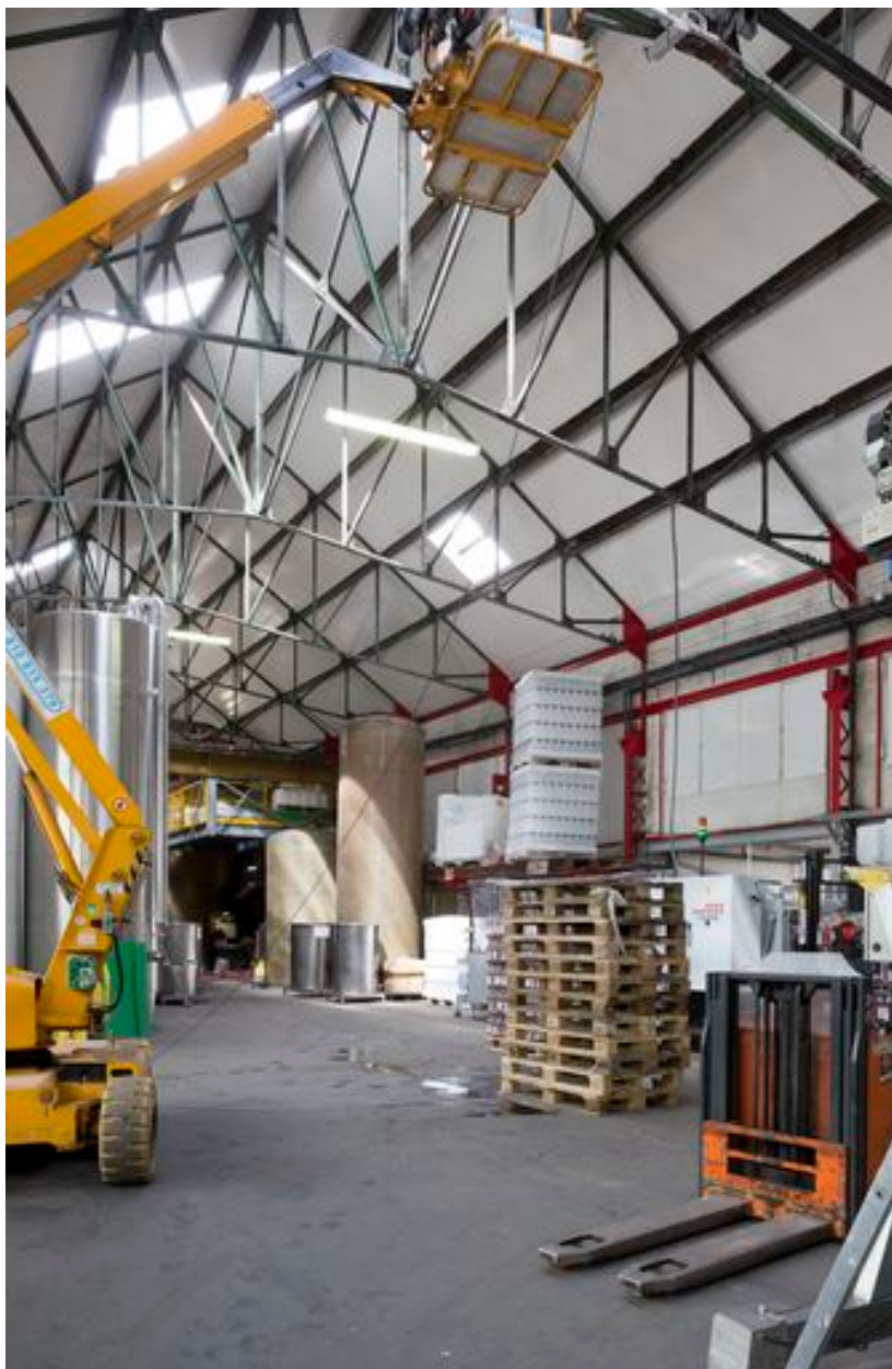
20 boulevard de Cardiff : Charpente métallique.
