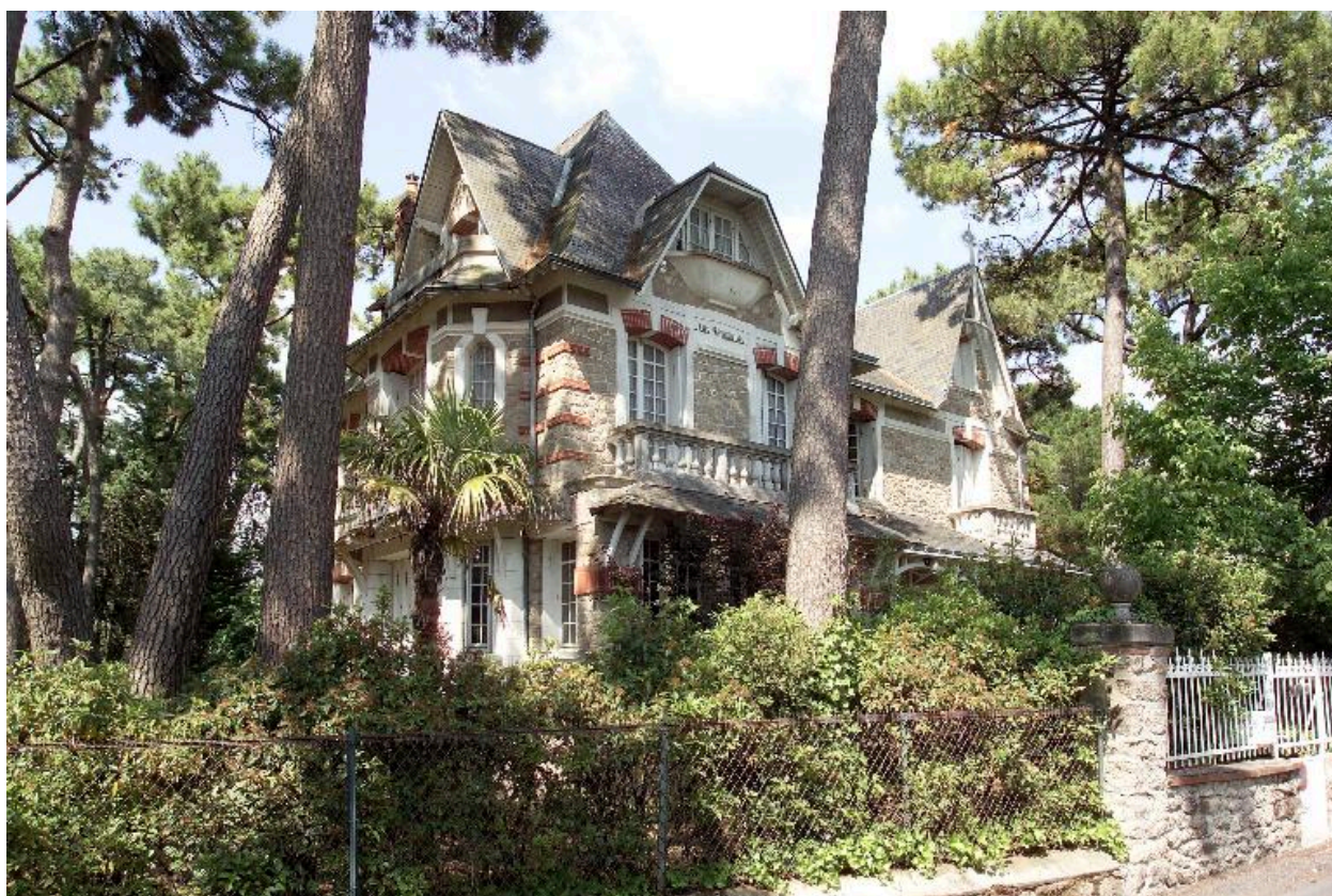
Vue d'ensemble de la villa.
