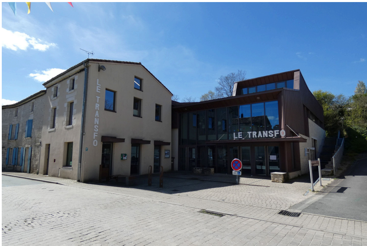
Le Transfo vu depuis le nord-est.
