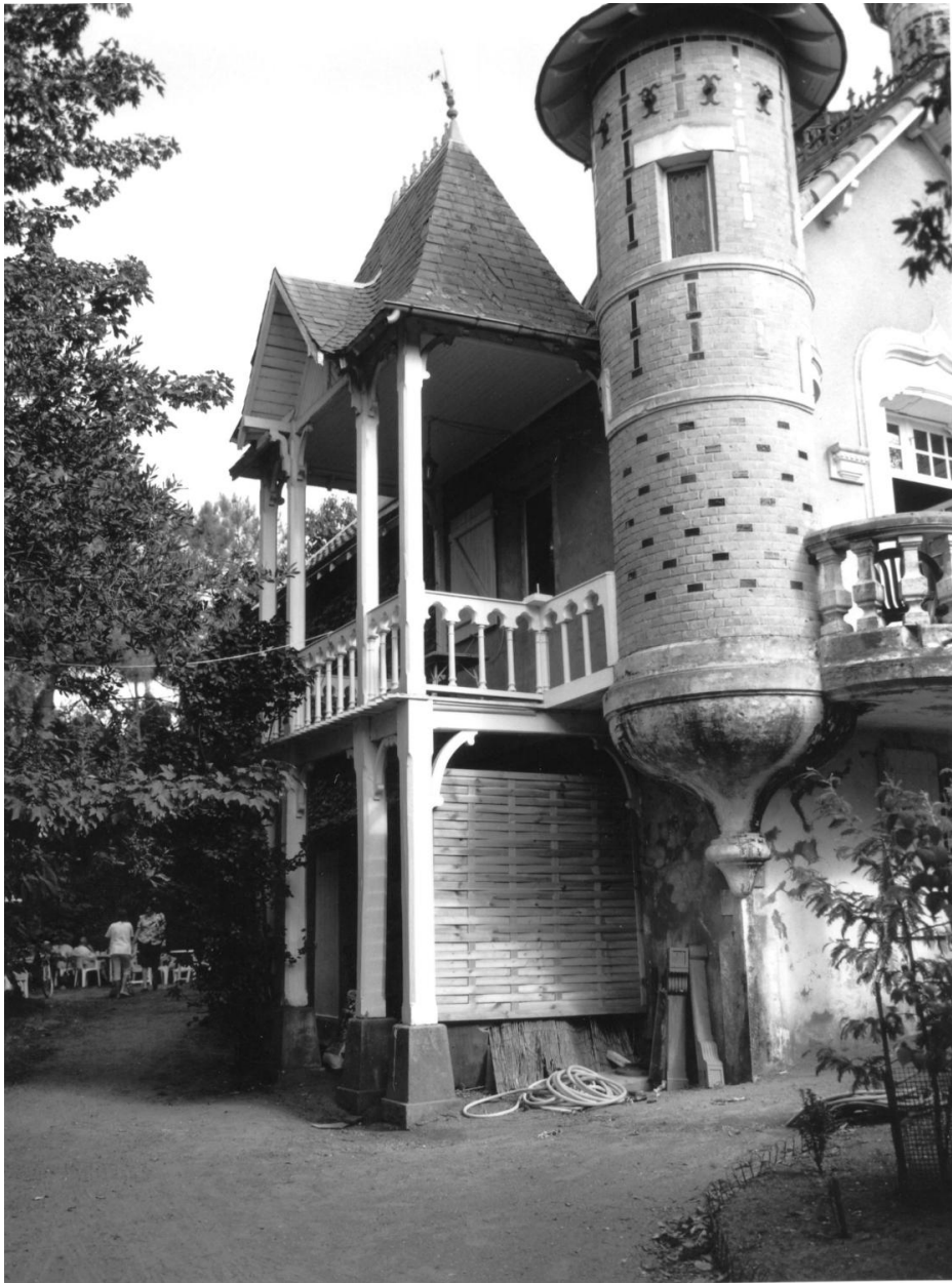
Elévation latérale nord, échauguette et porche.
