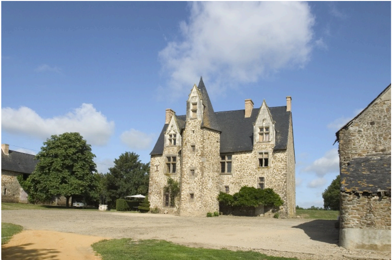
La façade principale du logis vue depuis l'est.
