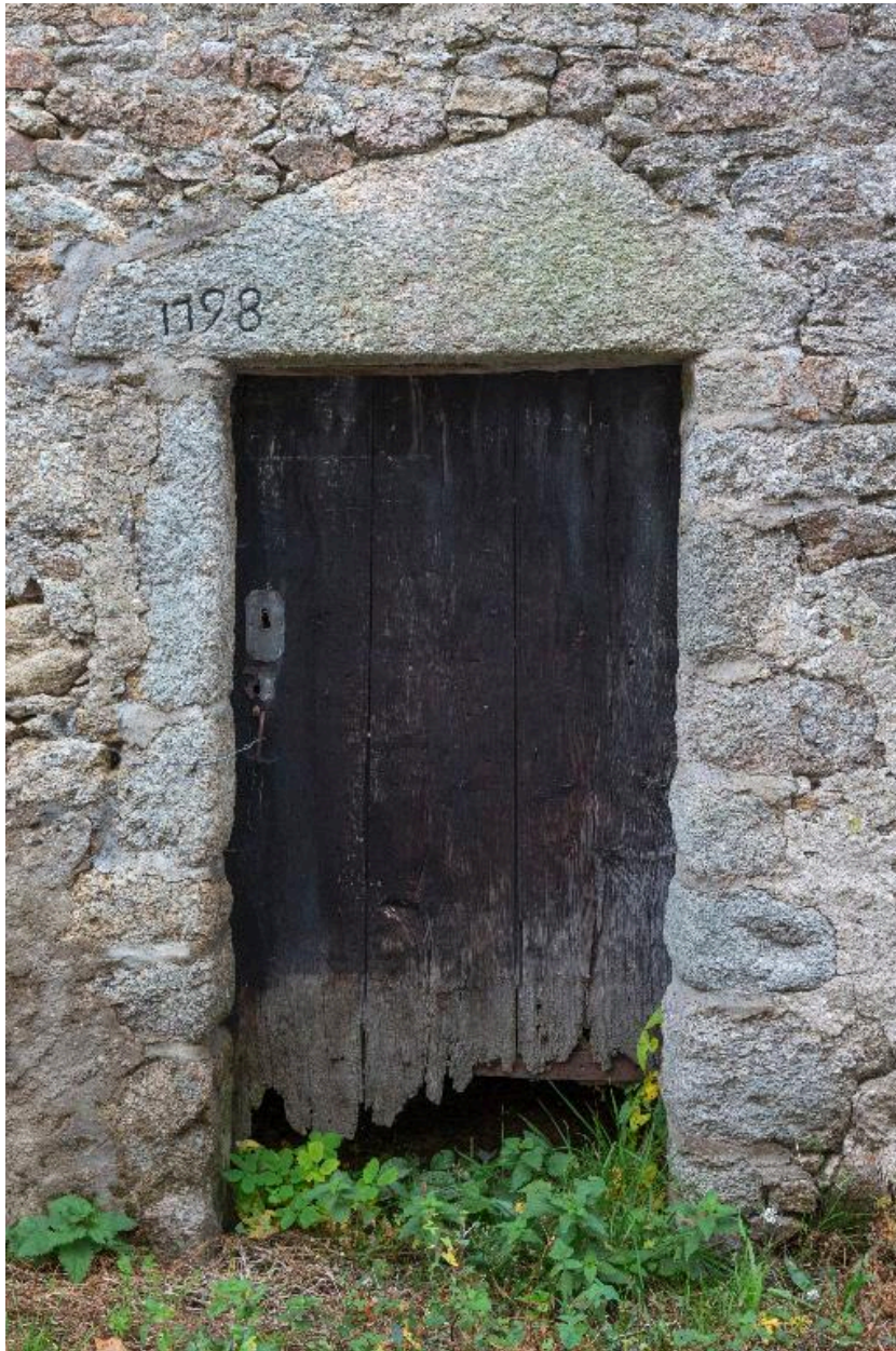
Linteau de maison gravé portant la date "1798", AW01-214, cadastre 2018.
